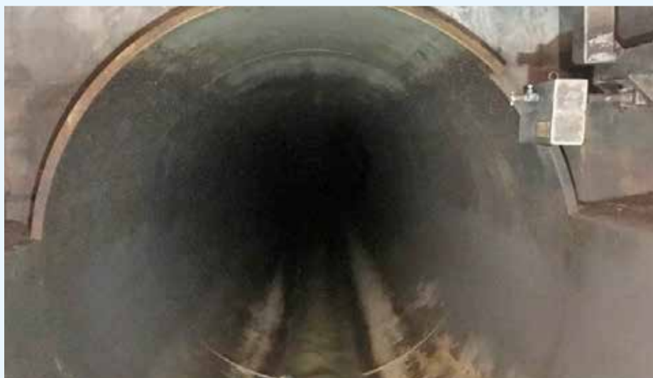
Das RÜB 2 mit einem Rohrdurchmesser von 2,3 Meter. Das Foto ist bei Trockenwetter entstanden und zeigt die reine Menge des Abwassers, welches durch das Becken läuft. Bei Regenwetter bleibt diese gleich! Das restliche Volumen steht für das Regenwasser zur Verfügung. Hiermit erklärt sich auch, dass das Abwasser extrem stark verdünnt wird, bevor es durch die Rechenanlage in den Bach abgeleitet wird.
